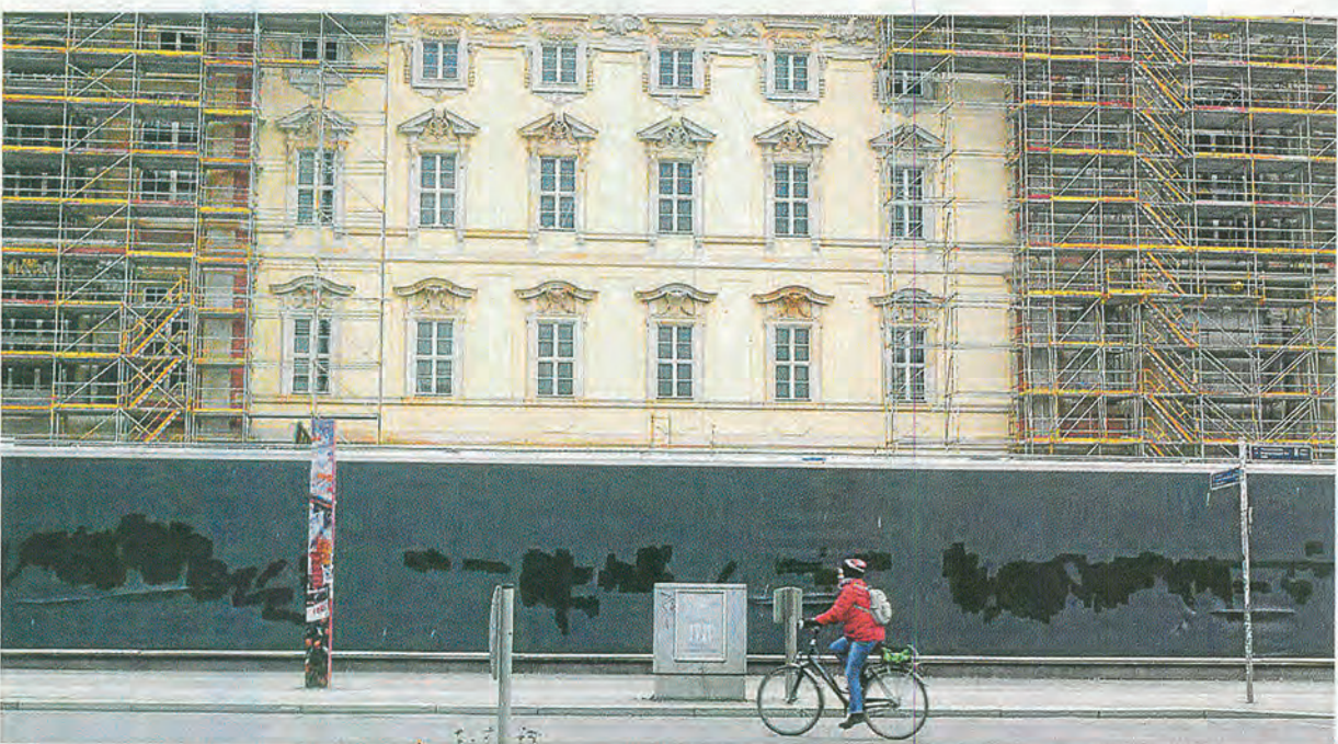
Barock: An der Seite zum Lustgarten sind die Baugerüste bereits gefallen und machen den Blick auf die rekonstruierte Fassade frei.
