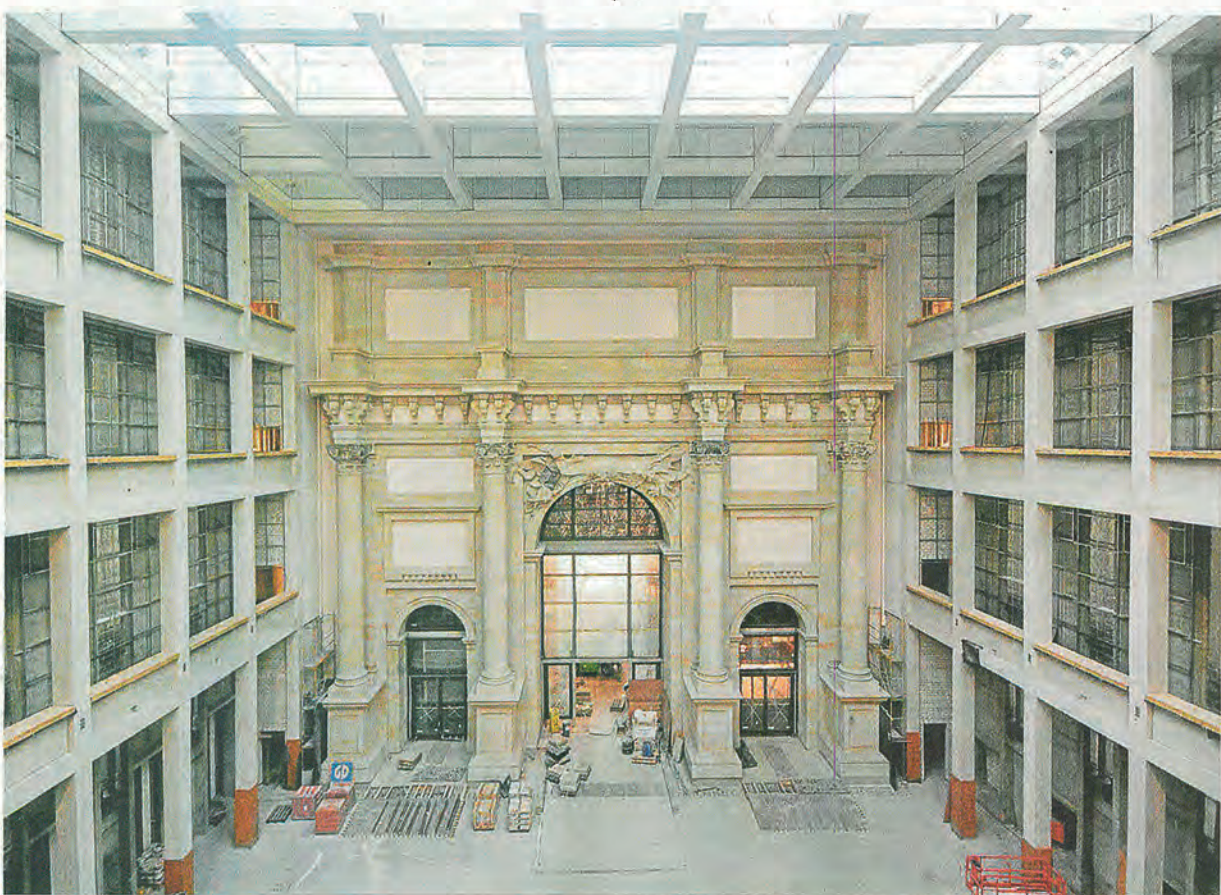
Alt und modern: Im Foyer wird das rekonstruierte Innenportal von einer Galerie in jetziger Architektursprache umrahmt.
